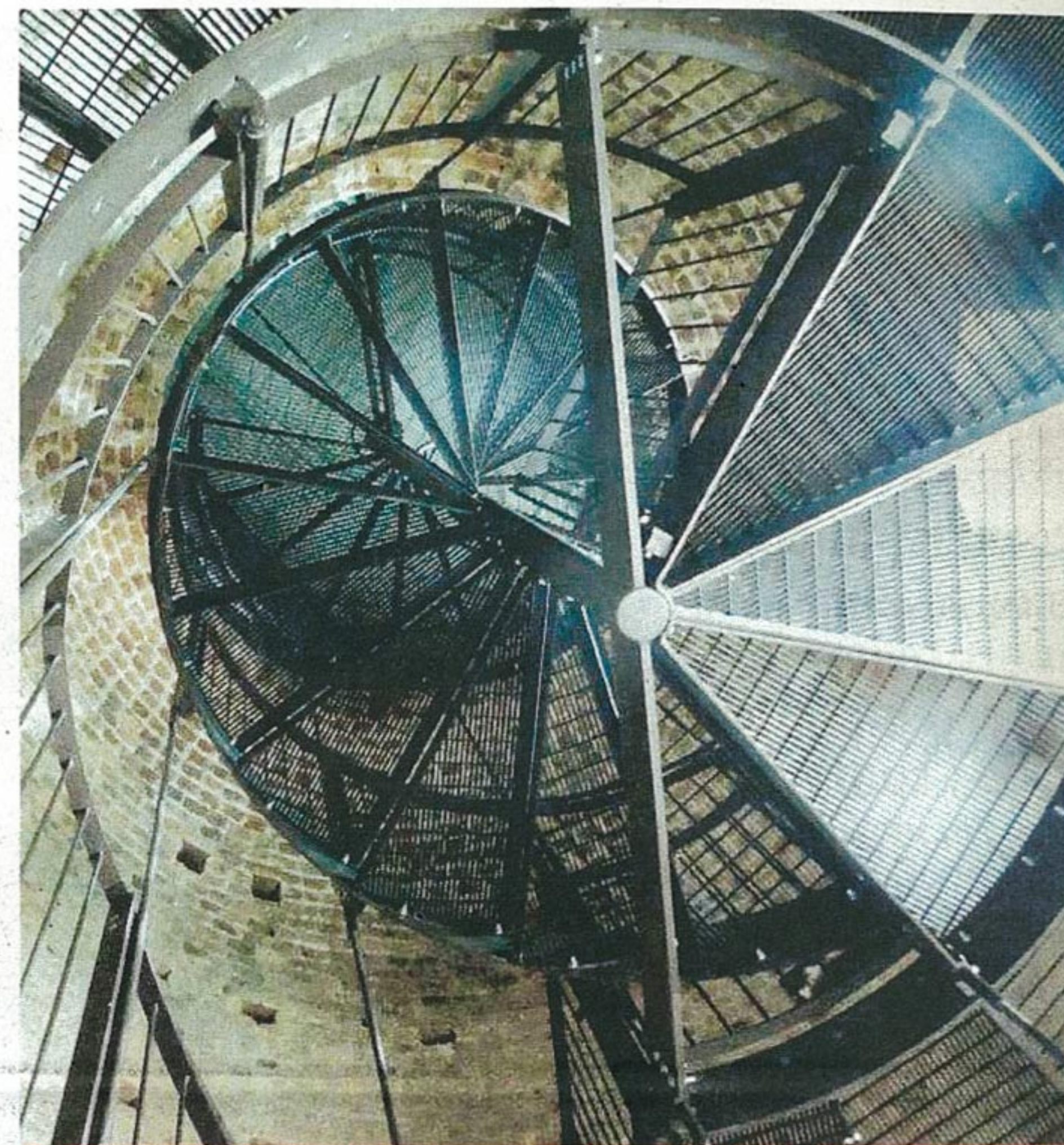
Una veduta suggestiva. La torre cornelianese ha una base decagonale e al suo interno è stata installata una moderna scala a chiocciola
