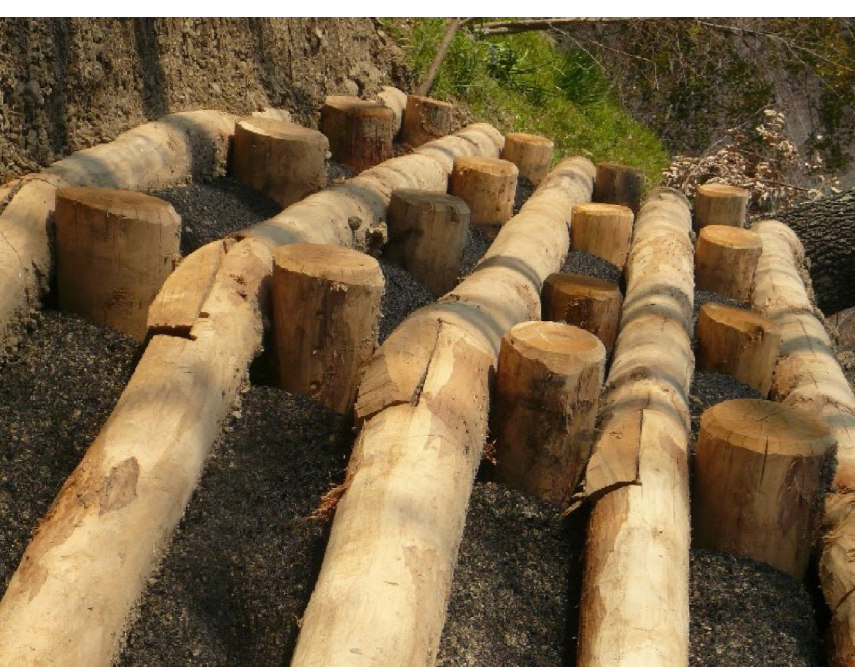
foto di esempio di palificazioni
