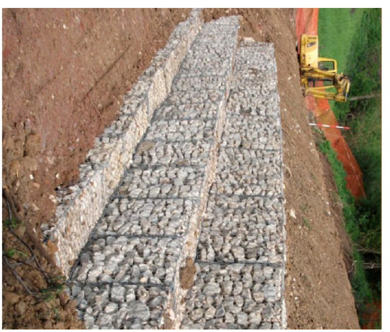
foto di esempio di gabbioni
