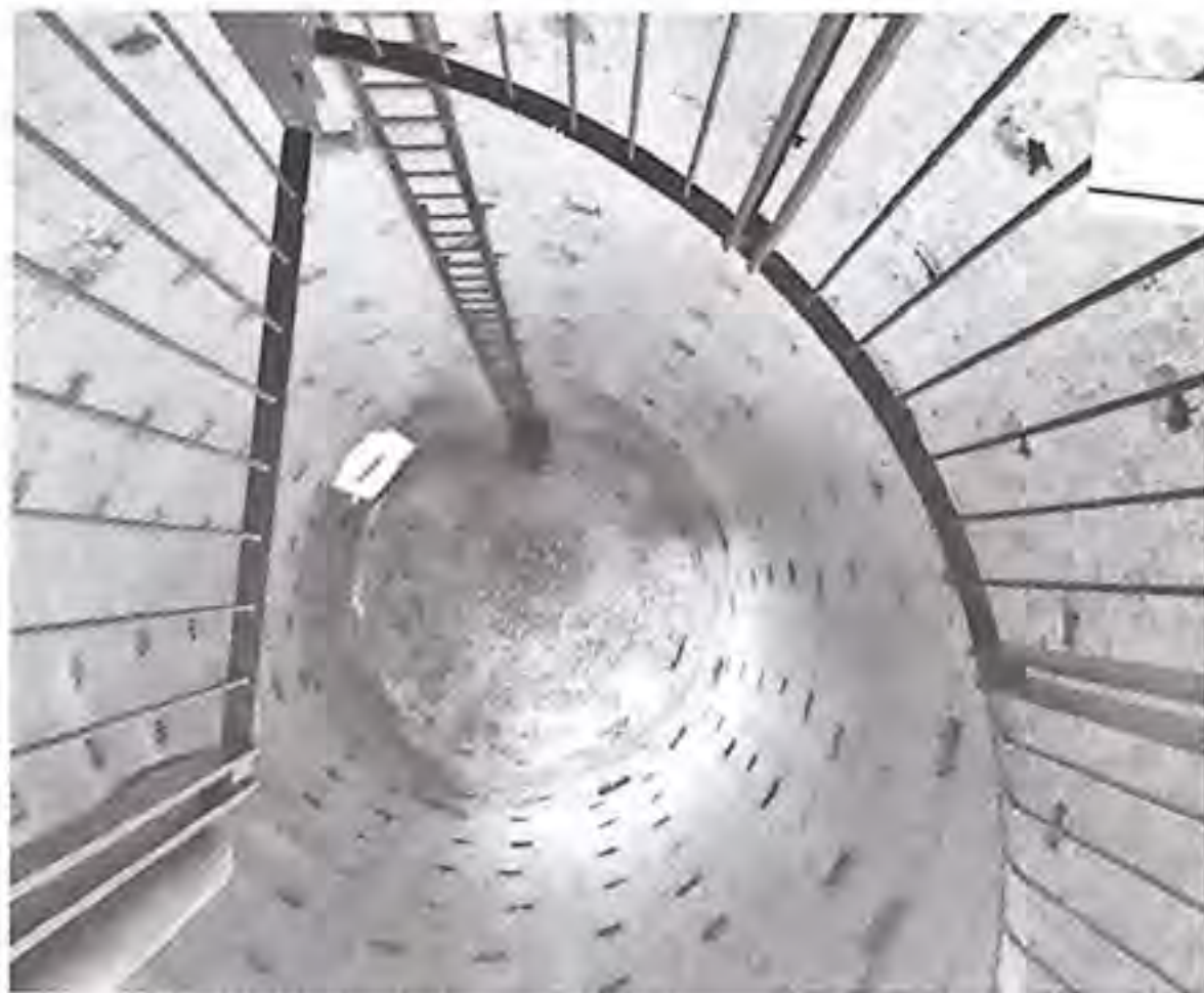
La cupola interna visibile salendo la scala, dopo la rimozione del telone.
